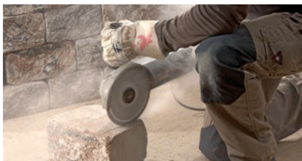
Kürzen der Steine mit Trennschleifer
